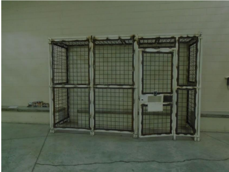
Figure 23 : Espace de programmation réservé au groupe de détenus en isolement, Centre correctionnel du Centre-Est
