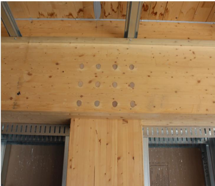
**Figure 4.8 – Assemblage dissimulé de Nordic, Québec**
