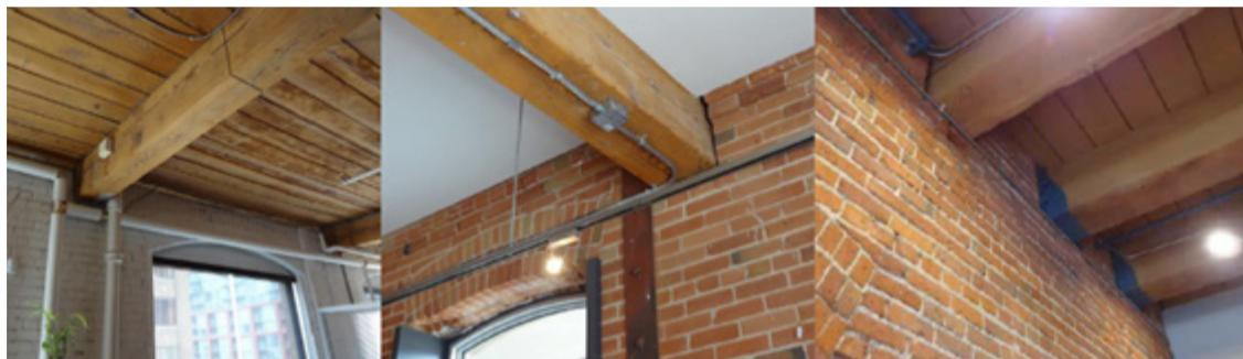
**Figure 2.3 – Raccordements typiques des briques et des poutres (Koo, 2013). Les poutres sont directement raccordées à la brique, sans dispositif visible pour contrer le retrait différentiel.**
