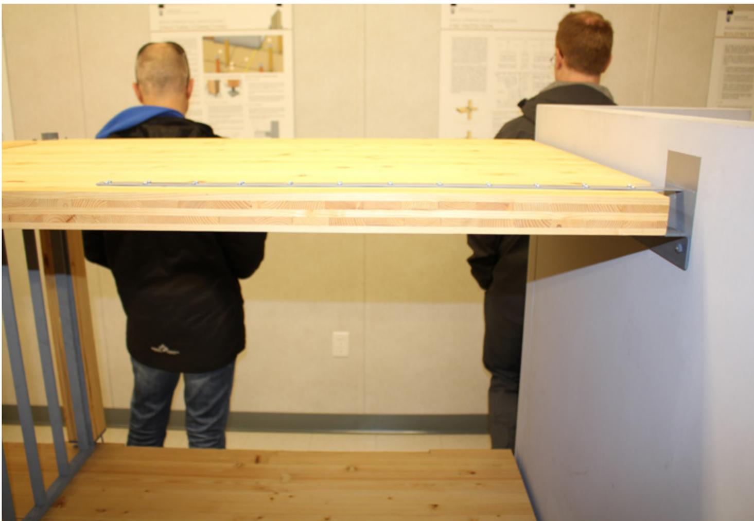
Figure 4.7 – Brock Commons de l'Université de la Colombie-Britannique – Démonstration d'un assemblage de panneau de bois lamellé-croisé à un mur de contreventement en béton à l'aide de sangles de tension et par connexion à fentes vertical (Photo : D. Moses)
