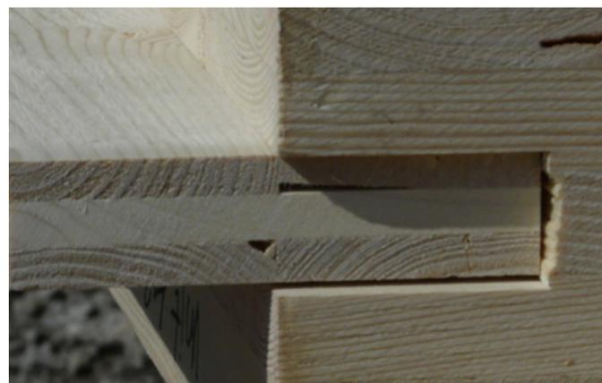
Figure 4.6 – Exemple d'assemblage de panneaux « mur à mur » (Photo: D. Moses).
