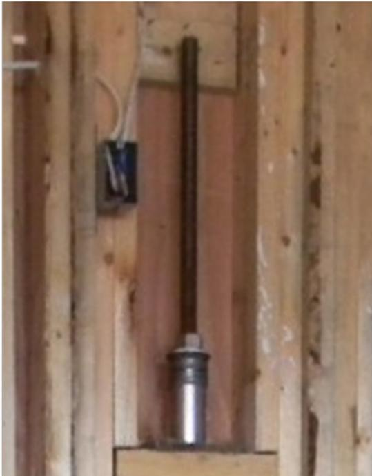
**Figure 4.4 – Exemple de système d'ancrages de retenue avec compensateur de retrait (Photo : M. Alexander)**
