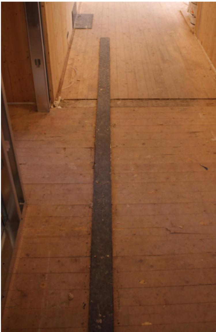
Figure 4.5 – Exemple de traverse longitudinale dans Origine, à Québec (Photo : D. Moses)
