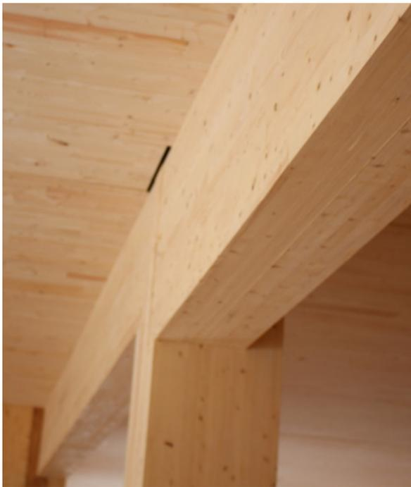
Figure 2.14 – Origine, ville de Québec. Bâtiment de 13 étages à poteaux et à poutres avec du bois lamellé-croisé (photo : D. Moses)
