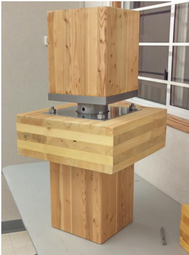
**Figure 2.8 – Détail de panneaux de plancher de CLT avec des colonnes de bois lamellé-collé au-dessus et au-dessous; tiré du projet de démonstration de la résidence Brock Commons de l'Université de la Colombie-Britannique (photo : D. Moses)**
