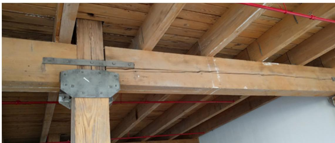
**Figure 2.4 – Construction en gros bois d'œuvre de sciage (photo : A. Franco)**
