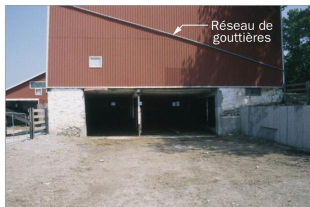
**Figure 2.** Un réseau de gouttières éloigne l'eau non contaminée de la cour d'élevage extérieure.
