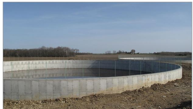
**Figure 1.** Il est possible de recourir à un réservoir en béton découvert pour emmagasiner les eaux de ruissellement.
