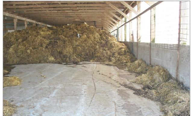
**Figure 3.** La pose d'un toit au-dessus d'une installation permanente de stockage d'éléments nutritifs solides élimine le ruissellement.
