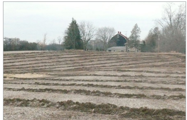
Figure 3. Les rangées parallèles de sol remblayé indiquent l'emplacement des tuyaux de drainage installés depuis peu dans ce champ.
