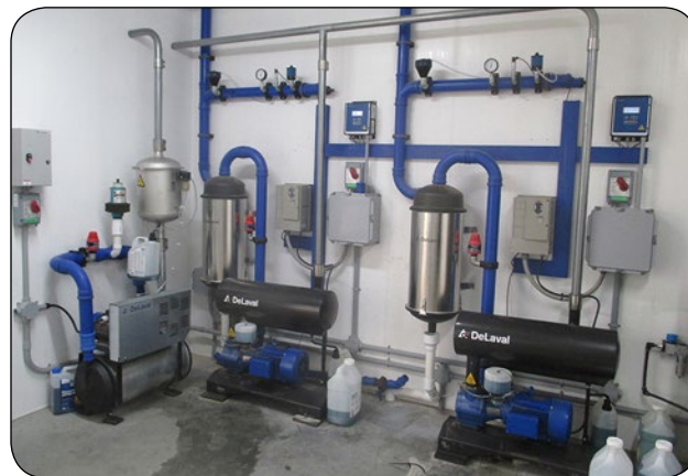
Figure 1. Local technique exempt d'objets encombrants, de poussière et de débris. Source : Heartland Farm Mutual, Ontario.
