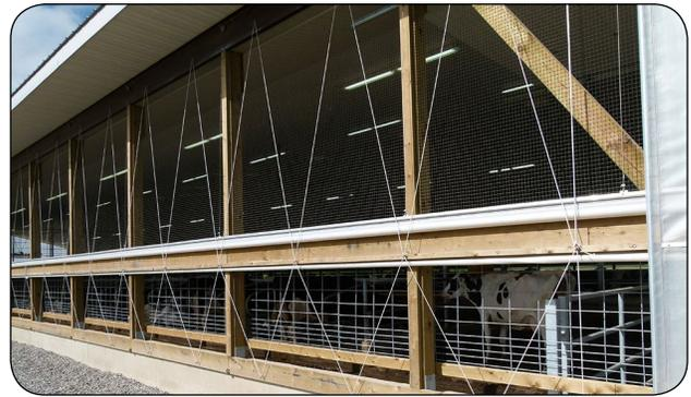
**Figure 3.** Entrée d'air latérale avec grillage de protection contre les oiseaux dans la partie supérieure.
