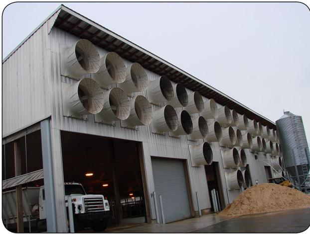
**Figure 9.** Ventilation longitudinale servant à rafraîchir les vaches.
