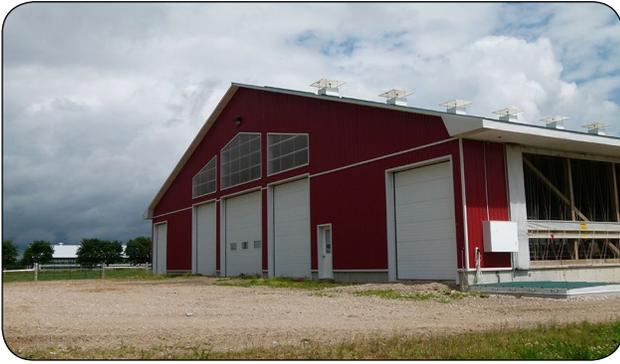
**Figure 2.** Ventilation naturelle d'une étable laitière.
