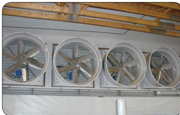
**Figure 6.** Les ventilateurs fournissent l'énergie nécessaire pour déplacer l'air et le renouveler.
