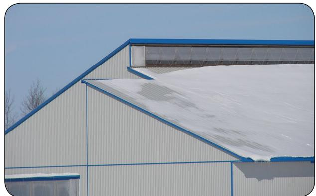
**Figure 5.** Faîte modifié créant une ouverture de faîte d'un seul côté
