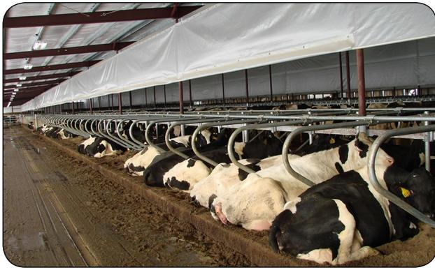
**Figure 11.** Des déflecteurs servent à augmenter la circulation d'air à la hauteur des vaches.
