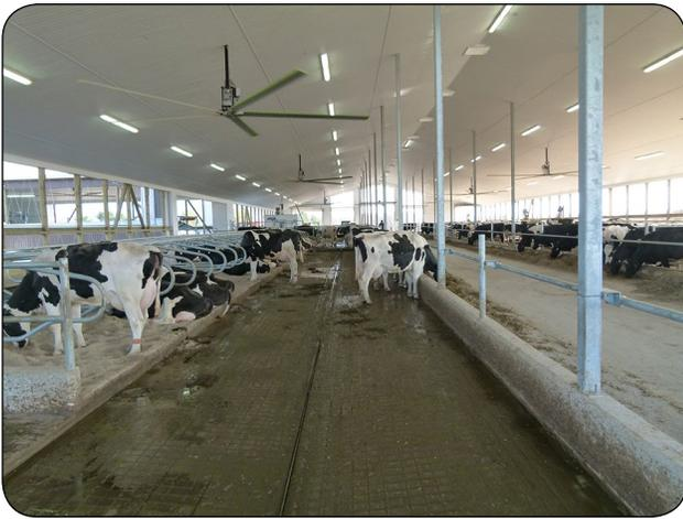
**Figure 8.** Installer les ventilateurs HVLS au-dessus des logettes pour le refroidissement.
