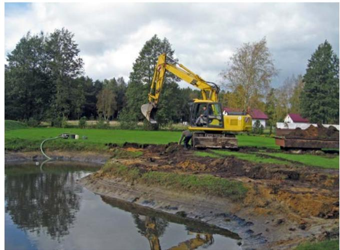
**Figure 8.25. Exemple d'un étang de décantation tapissé d'argile.**
