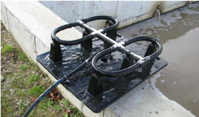
**Figure 11.3.** Diffuseur d'aération par le fond.
