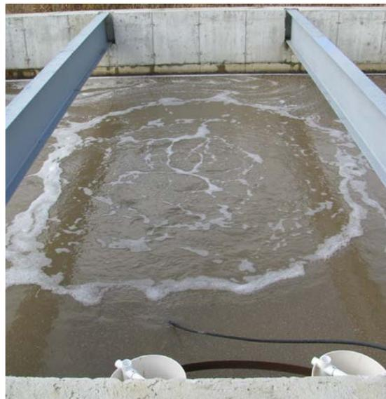
Figure 8.37. Perturbation en surface par un diffuseur.
