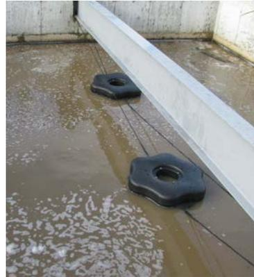
**Figure 8.42. Système d'aération installé à la surface.**
