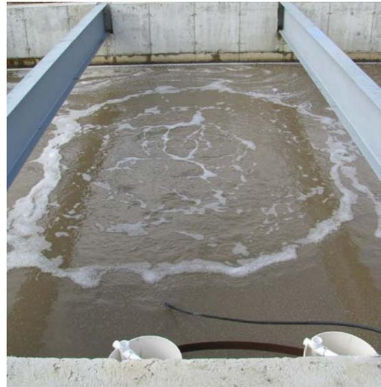
**Figure 11.4.** Bulles d'air s'élevant à la surface de la cellule.
