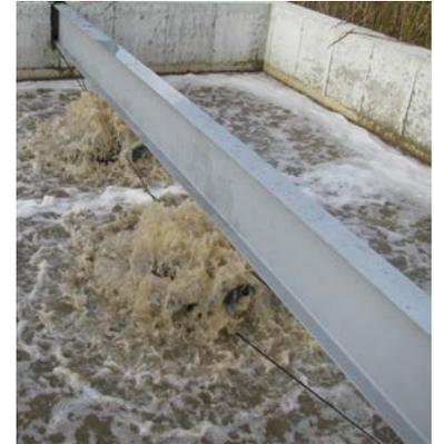
**Figure 8.43. Aération de surface en service.**
