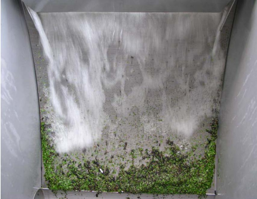
**Figure 8.6. Solides grossiers collectés par un filtre à tamis parabolique.**
