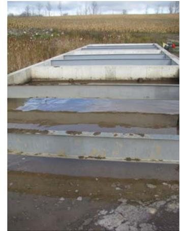
**Figure 8.27. Exemple d'un bassin de décantation en béton avec une série de trois cellules.**
