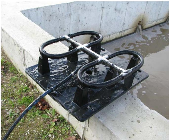
Figure 8.36. Diffuseur d'aération par le fond.
