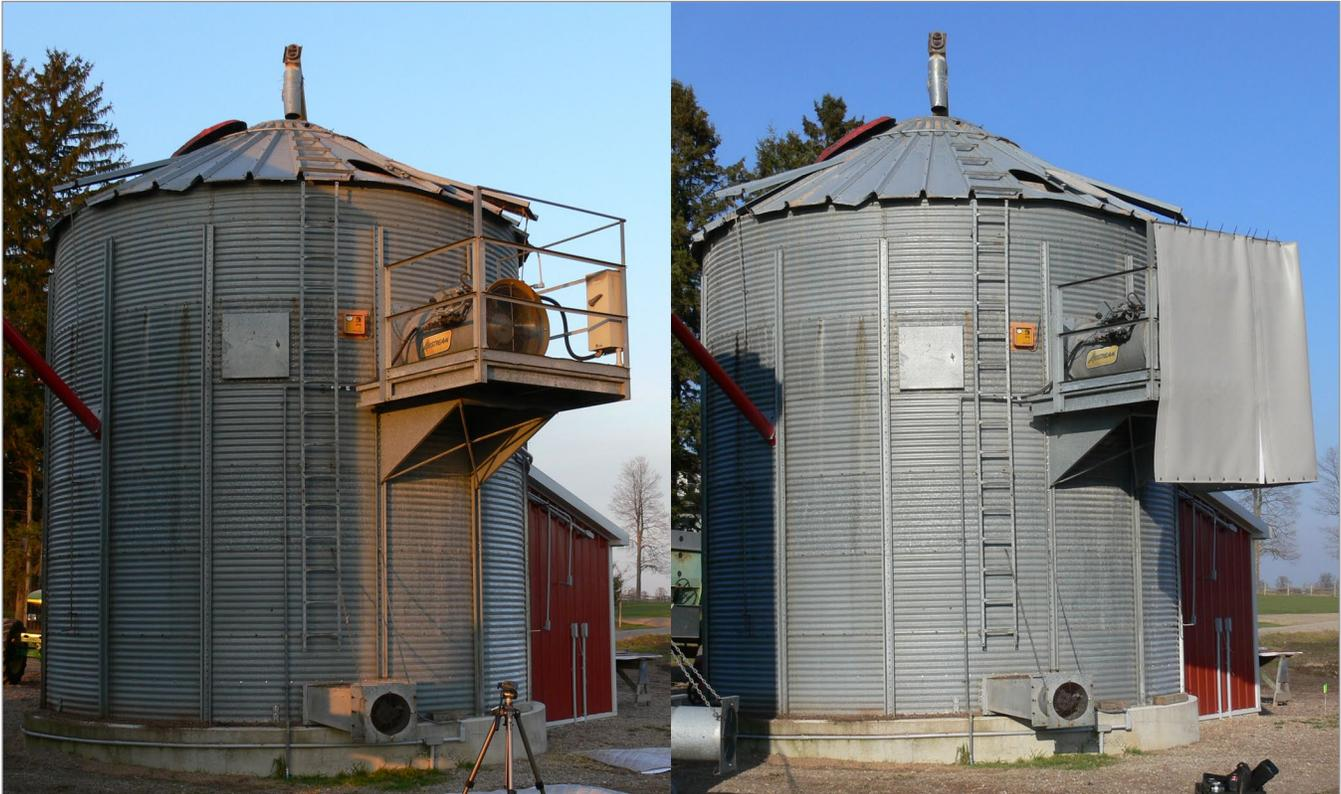
**Figure 5.** Bâche acoustique épaisse et souple, résistante à la chaleur et aux intempéries servant à atténuer le bruit produit par le séchoir à grains et à respecter ainsi la tranquillité des voisins. Trois panneaux de 1,2 m x 2,4 m (4 pi x 8 pi), de 25 mm (1 po) d'épaisseur et d'un poids de 36 kg chacun ont été réunis par des bandes de Velcro® et suspendus à l'aide d'anneaux et d'attaches de plastique robustes.
