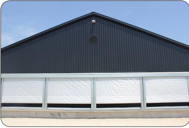
**Figure 11.** Tapis humides du système de refroidissement par évaporation, partiellement recouverts d'une bâche blanche protectrice.
