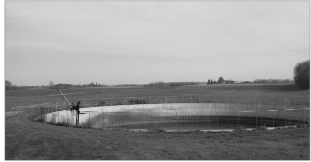
Figure 3. Vue d'une structure de stockage extérieure à long terme.
