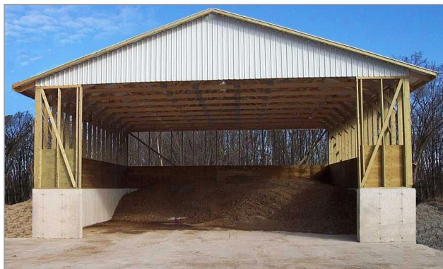
Figure 2. Une installation d'entreposage munie d'un toit réduit ou élimine le ruissellement provenant de MSNA solides.
