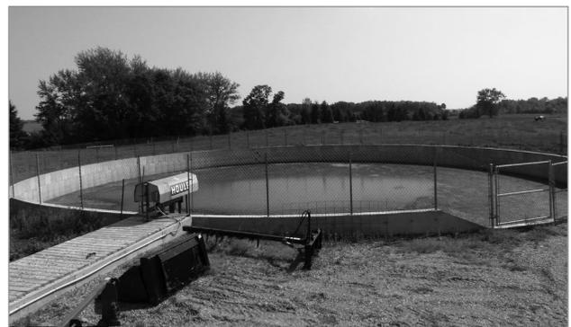
**Figure 1.** Installation permanente d'entreposage d'éléments nutritifs clôturée, en béton armé et conçue pour contenir du fumier ainsi que d'autres matières prescrites produites par une exploitation d'élevage.
