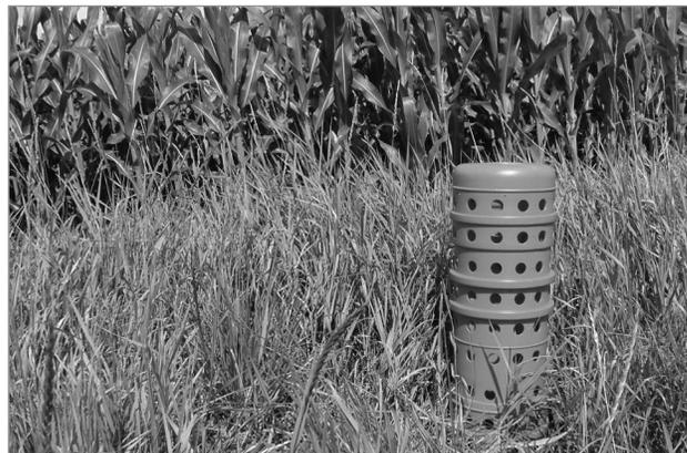
**Figure 4.** Avaloir (bassin récepteur) servant à drainer l'eau de surface.
