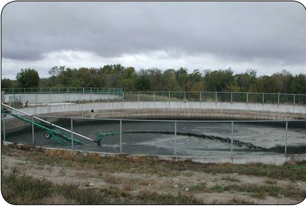
**Figure 6.** Agitation du fumier dans une aire d'entreposage en béton de 39 m (128 pi) de diamètre sur 5 m (16 pi) de profondeur.
