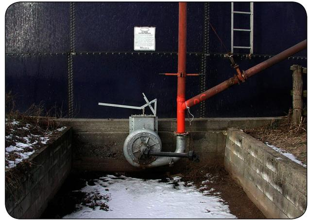
**Figure 3.** Pompe à fumier liquide montée sur la paroi d'une structure hors-sol en acier.
