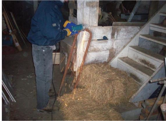
**Figure 1.3. Opération de meulage effectuée en présence de matériaux combustibles. Utiliser ce type de matériel hors du bâtiment et loin des combustibles ou mettre en place des mesures de protection pour réduire le risque d'inflammation.**
