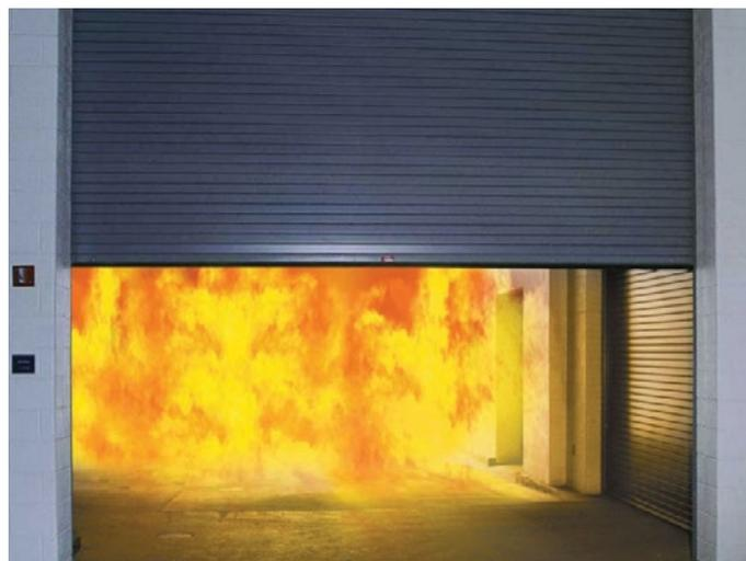
**Figure 3.8. Porte-rideau se fermant automatiquement en cas d'incendie afin de protéger un compartiment adjacent.**
