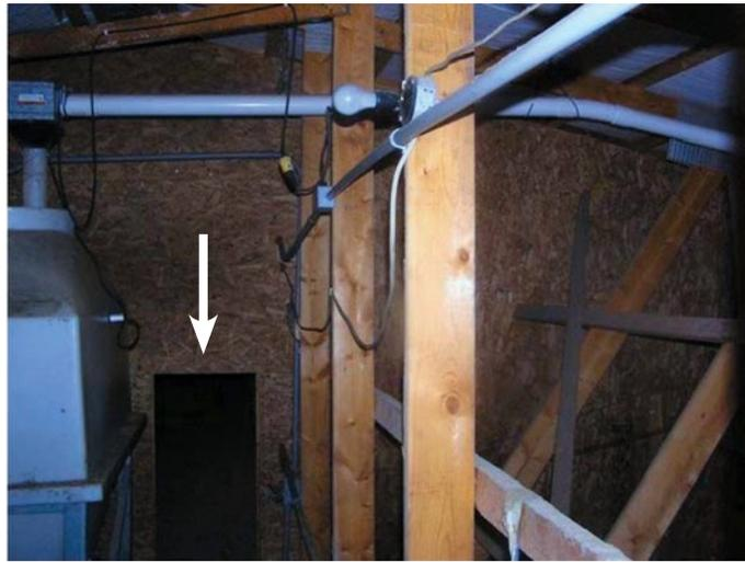
**Figure 3.7. Coupe-feu dans un vide sous-toit dont l'efficacité à contenir un incendie est compromise par l'ouverture qui y a été pratiquée (indiquée par la flèche).**
