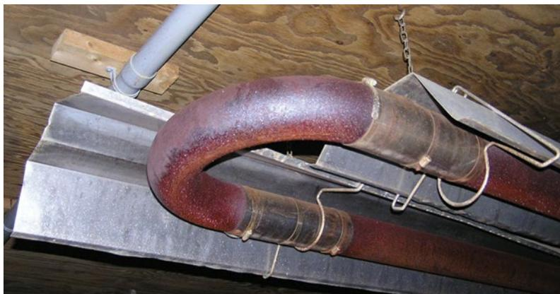
**Figure 2.9. Absence d'écran thermique au-dessus d'un tube radiant.**
