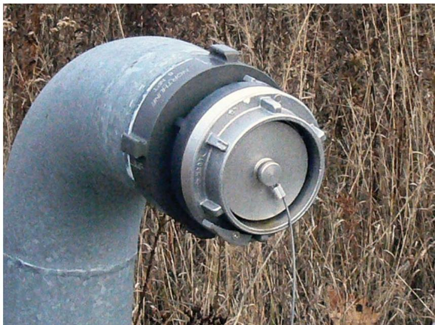
Figure 4.6. Raccord de la prise d'eau sèche.
