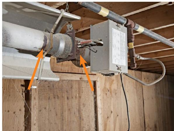
**Figure 2.8b. Devant d'un générateur de chaleur à tubes radiants situé à l'intérieur du même poulailler de poulets à griller. De la corrosion est présente.**
