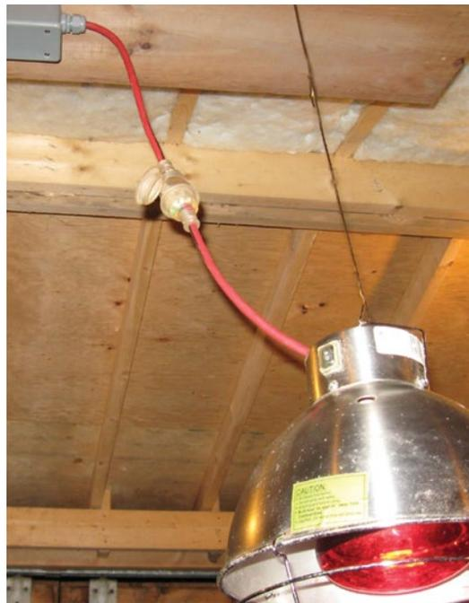
**Figure 3.13. Lampe à rayons infrarouges branchée directement à une prise électrique à l'épreuve de l'eau au moyen d'une rallonge pourvue d'un capuchon de connexion, également à l'épreuve de l'eau, qui permet de débrancher l'appareil d'éclairage. Au débranchement de l'appareil, le capuchon est replacé sur l'extrémité femelle de la rallonge, de manière à protéger celle-ci de la corrosion.**
