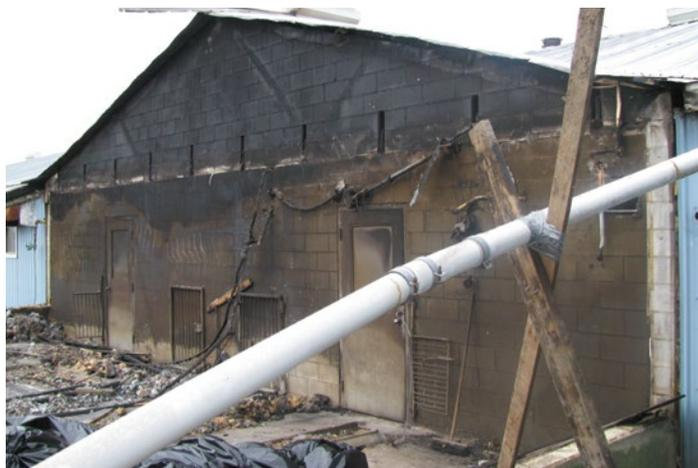
**Figure 3.1. Exemple de séparation coupe-feu ayant joué son rôle dans une porcherie en empêchant le feu de se propager au reste du bâtiment.**
