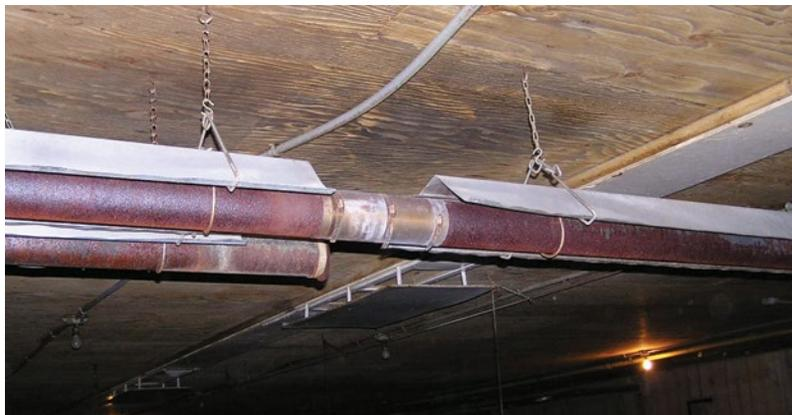
**Figure 1.4. Générateur de chaleur à tubes radiants dont les écrans ont été déplacés. Remarquer les traces de carbonisation au plafond.**
