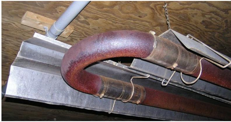
**Figure 1.5. Absence d'écran protecteur au-dessus d'un tube radiant.**
