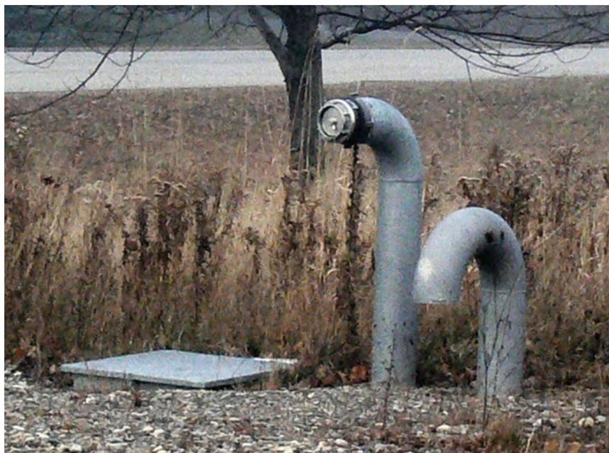
Figure 4.5. Vue d'ensemble d'une prise d'eau sèche.
