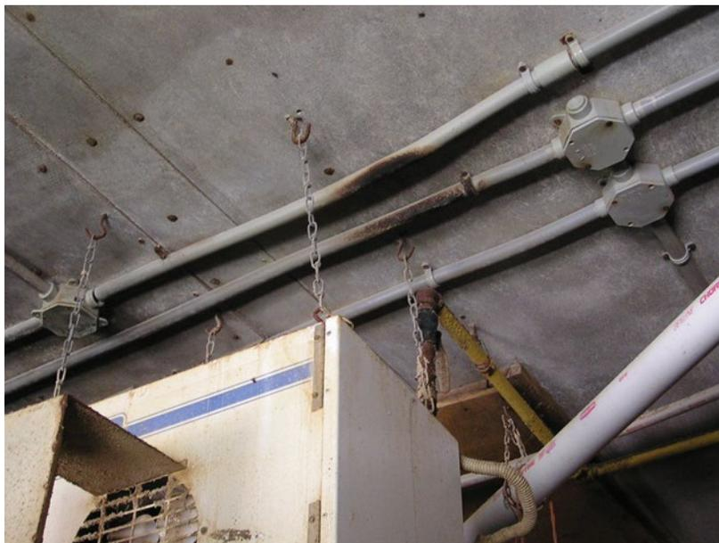
**Figure 3.14. Aérotherme solidement fixé à l'aide de quatre chaînes pour palan. La photo montre des traces de carbonisation laissées sur les canalisations électriques par un robinet de gaz défectueux.**
