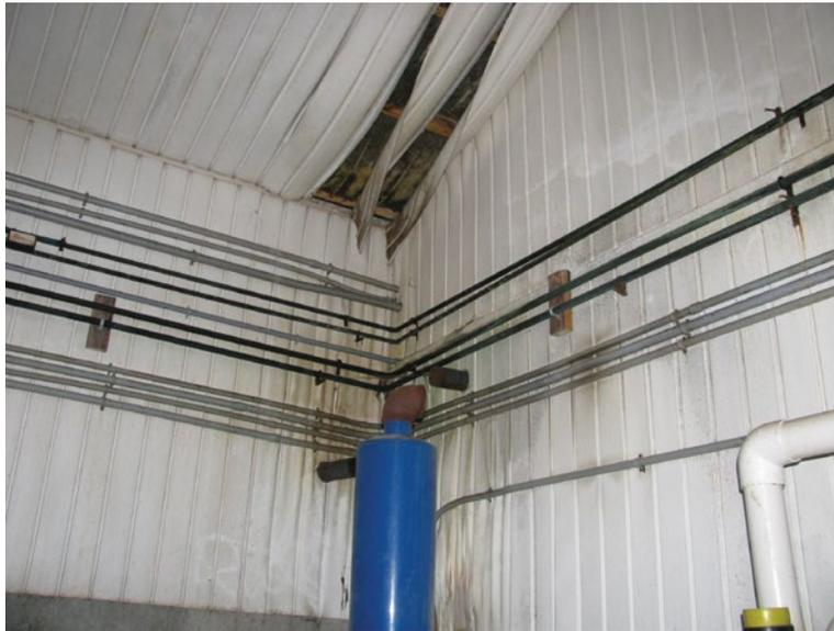
**Figure 3.11. Revêtement en vinyle déformé par la chaleur au plafond.**
