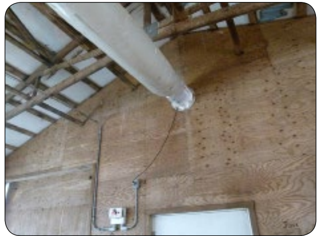
Figure 2. La grosseur de la gaine de diffusion d'air est fonction de la capacité du ventilateur.
