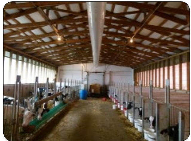
Figure 1. Les systèmes de VGDAPP améliorent la ventilation des étables à veaux.
