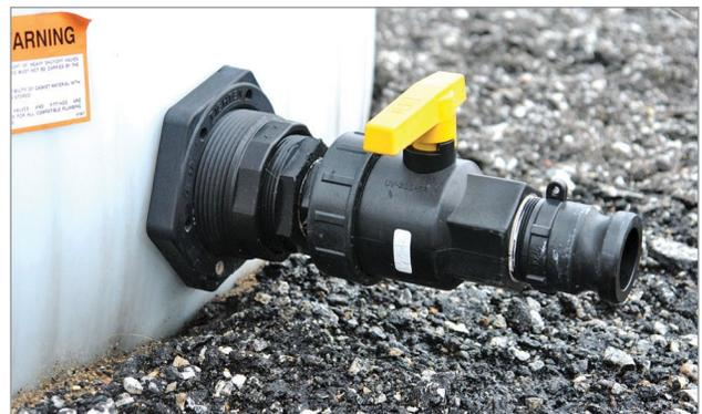
**Figure 4.** Robinet à bille léger fixé à un réservoir en polyéthylène.
