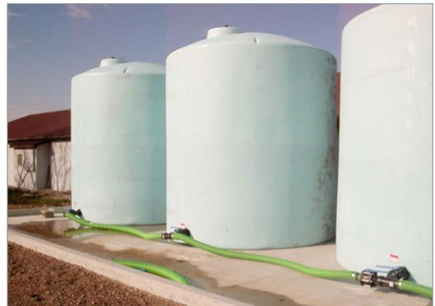
**Figure 1.** Réservoirs en polyéthylène avec digue de rétention.
