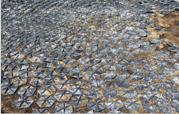
Figure 12. Couverture perméable d'une structure de stockage de fumier liquide composée de disques en plastique en forme d'hexagone.
