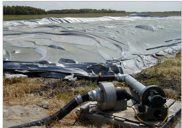
Figure 6. Couverture imperméable à pression d'air négative sur une structure de stockage de fumier en terre.
