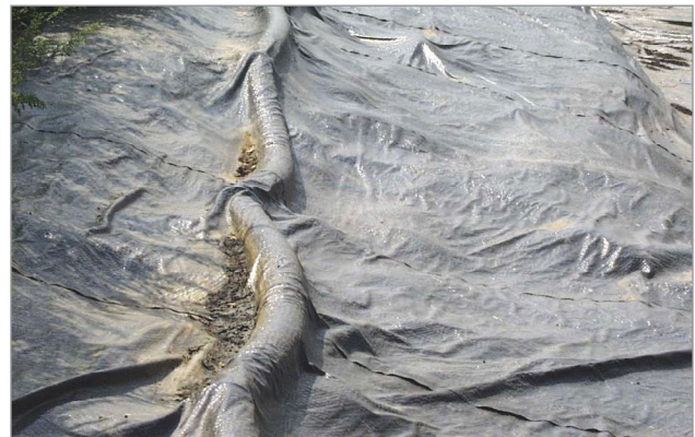
Figure 7. Couverture imperméable à pression d'air négative qui est tirée vers le bas.
