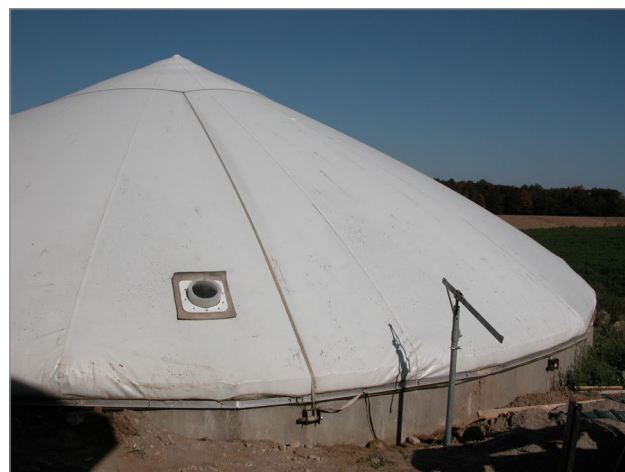
Figure 2. Couverture imperméable de stockage de fumier à pression d'air positive.
