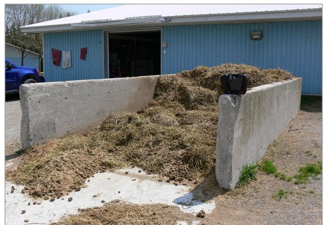
**Figure 1.** Structure de stockage de fumier en béton armé comportant trois parois et située à côté d'une écurie.
