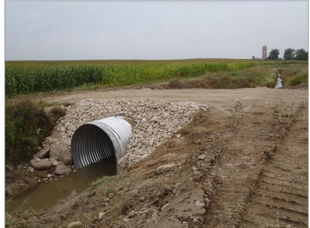
**Figure 1.** Passage (traverse) plus large récemment installé sur un drain. *Source* : Dietrich Engineering Limited, Waterloo, Ontario
