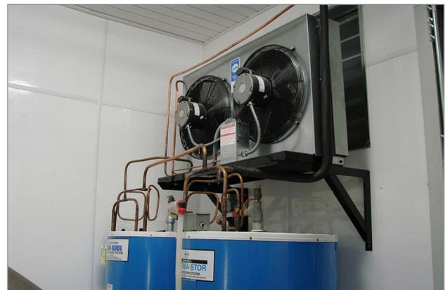
**Figure 11.** Récupérateur de chaleur pour le préchauffage des eaux de lavage.
