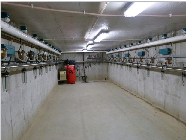
**Figure 5.** La pose de pulsateurs dans le sous-sol du centre de traite réduit le bruit dans la salle de traite.
