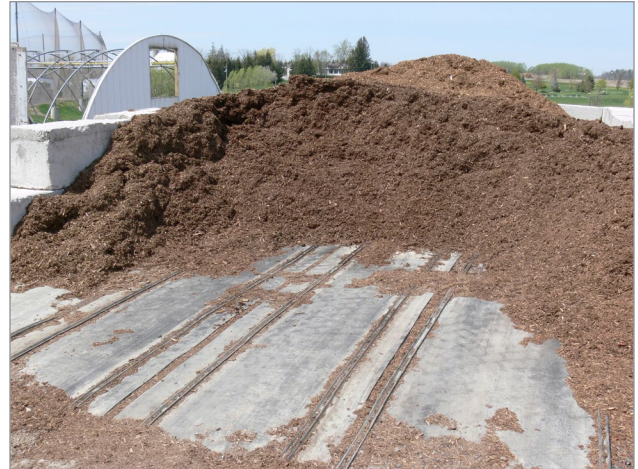
Figure 11. Une entreprise paysagiste utilise ici des tapis de convoyeurs d'occasion provenant d'une carrière pour protéger de l'orniérage le sol sous-jacent à un tas de compost.
