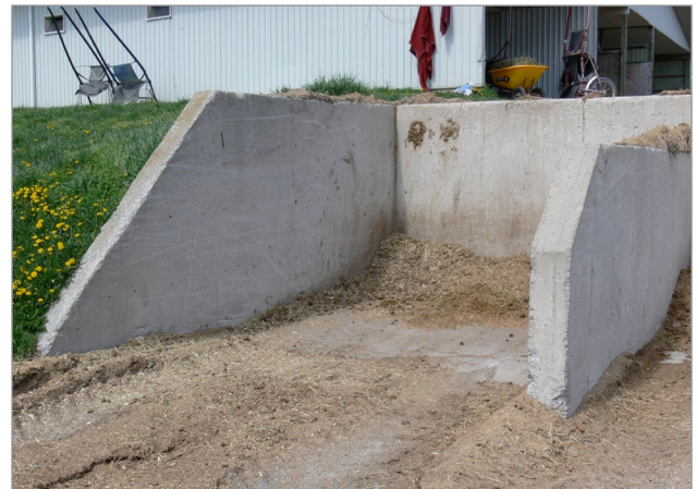
Figure 6. Une structure construite à flanc de colline facilite le déchargement des brouettes de fumier, pourvu que des dispositifs d'arrêt soient fixés au sommet de la paroi.
