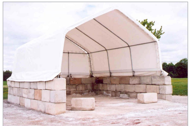
Figure 12. Une structure servant à stocker du sable peut aussi servir à garder le fumier de cheval au sec.
