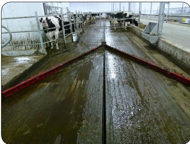
**Figure 4.** Système de racleur à tube qui achemine le fumier vers une rainure au centre.
