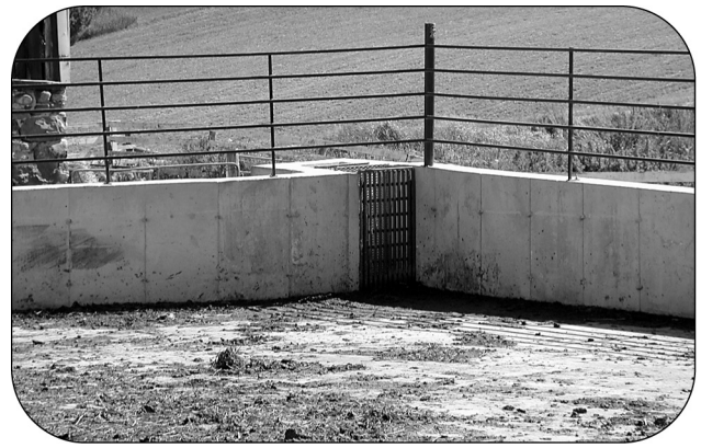
Figure 3. Le fait de placer trois tamis au point le plus bas de la ZCEP limite la quantité de matières solides qui atteignent la pompe et le bassin de rétention du système de bande de végétation filtrante.
