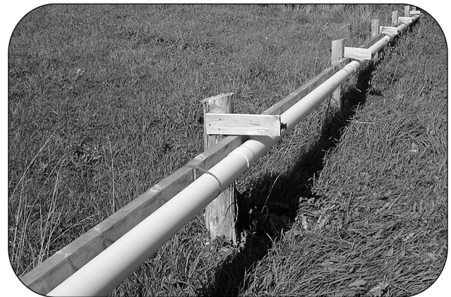
Figure 4. Quand une quantité suffisante d'eaux de ruissellement se retrouve dans le bassin de rétention, la pompe est actionnée et les eaux sont déversées dans un tuyau qui, à cette exploitation agricole, atteint une longueur de 40 m (130 pi) et est doté de trous de 1,9 cm (3/4 po) tous les 4,5 m (15 pi) afin d'être réparties uniformément dans toute la bande de végétation.
