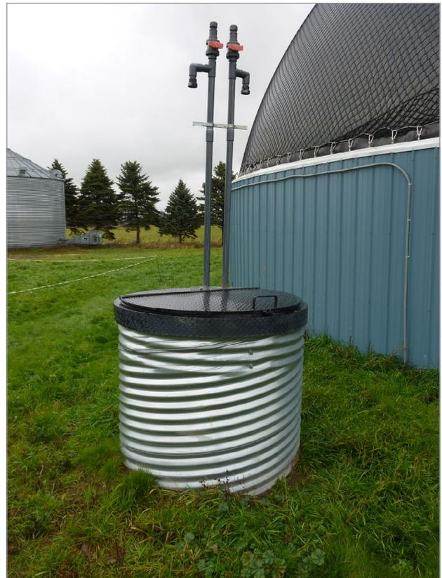
**Figure 5.** Point d'accès à la cuvette de condensation qui collecte l'humidité éliminée du biogaz.
