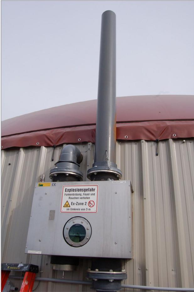
**Figure 4.** Soupape de décompression résistante au gel installée sur un digesteur anaérobie en Ontario.
