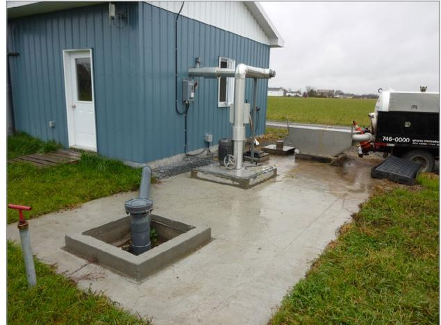
**Figure 2.** Réservoir enterré de stockage de co-substrat où des matières liquides ne provenant pas d'une exploitation agricole, comme des matières grasses, huiles et graisses, sont stockées temporairement.
