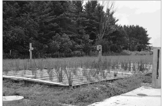
**Figure 6.** Ce milieu humide artificiel constitué de trois cellules sert à traiter les eaux de lavage du centre de traite d'une ferme de chèvres et également à traiter les effluents liquides d'un parc de stockage de fumier de 280 m<sup>2</sup>.
