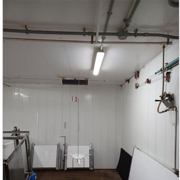
Figure 3. Luminaires linéaires à DEL installés dans un bâtiment de finition.
