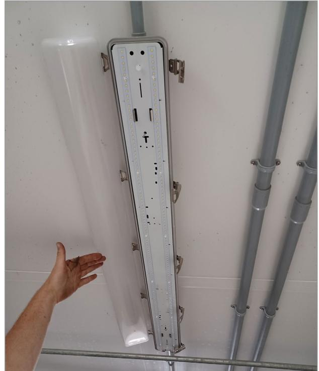
**Figure 4.** Intérieur d'un luminaire linéaire à DEL. Les DEL sont des dispositifs à semi-conducteurs. Chaque carré ici en est un. Le joint de la lentille rend ce luminaire étanche à la vapeur.
