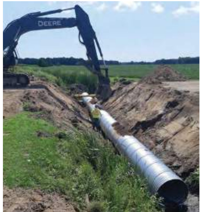
Figure A3-6. Placement d'un nouveau ponceau dans le cadre du remplacement d'un passage.
