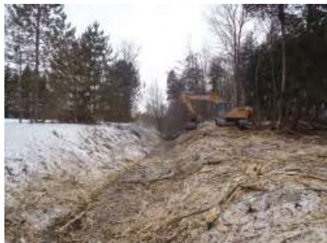
Figure A3-3. Débroussaillage des berges d'un drain. Source : Dietrich Engineering Ltd., Kitchener, Ontario
