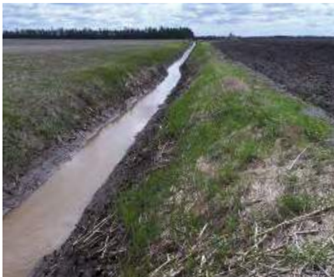
Figure A3-11. Nettoyage du fond d'un drain en gardant la végétation sur le talus.
