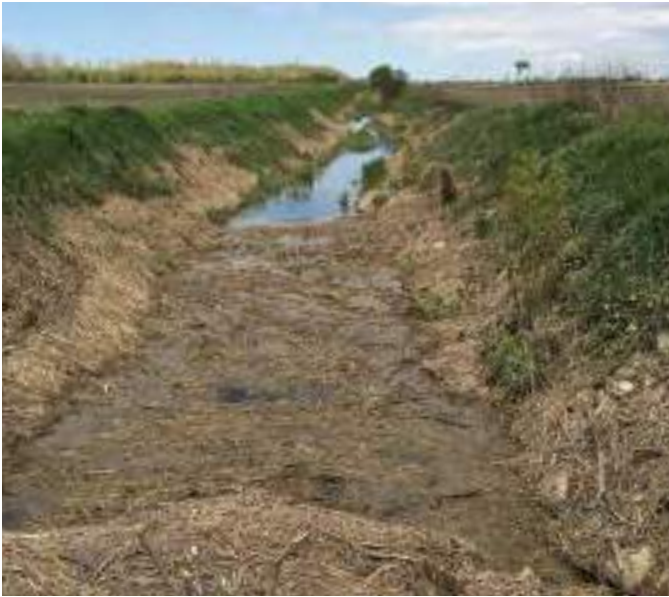
Figure A5-2. Obstruction dans le drain qui doit être enlevée par le propriétaire foncier.
