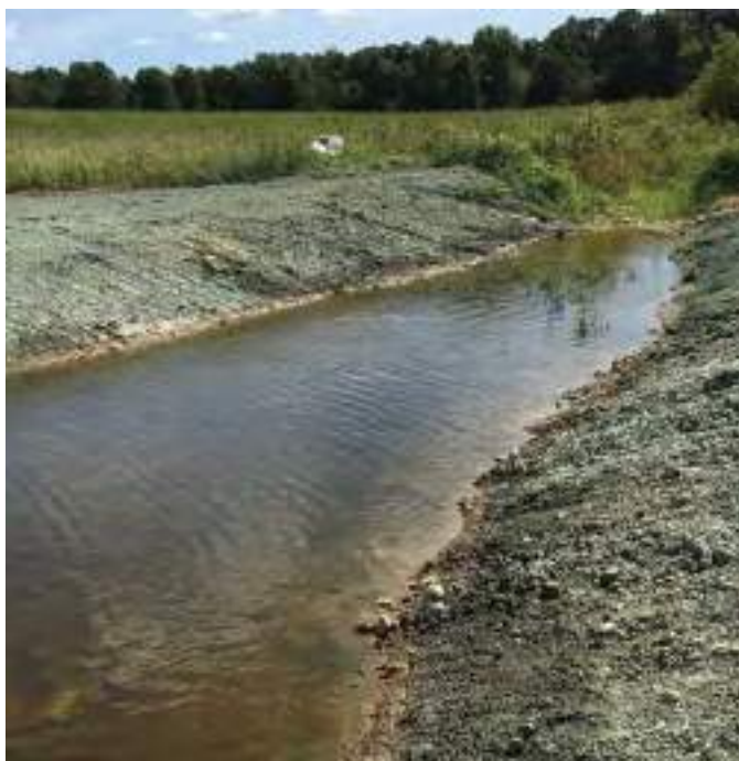
Figure A3-16. Utilisation d'un hydro-semoir sur les deux berges d'un canal de drainage.
