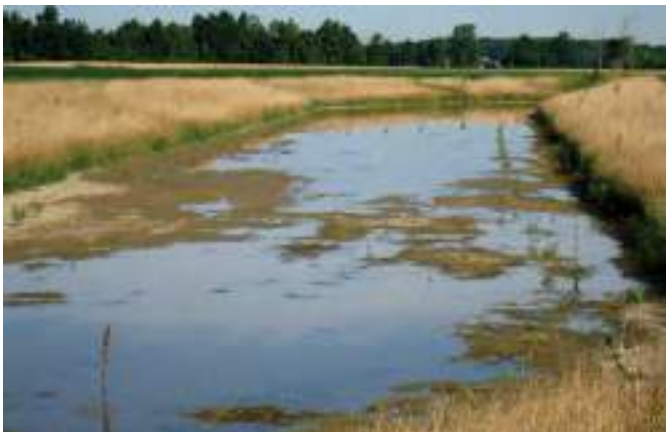
Figure B4-35. Canal autoformant (après la construction).
