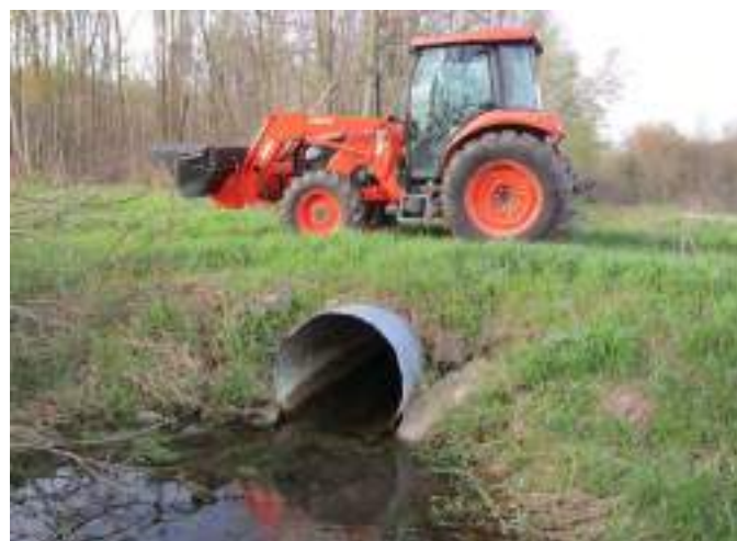
Figure A3-26. Passage de ferme au-dessus d'un drain pour permettre l'accès à une partie de la propriété séparée en raison du drain.
