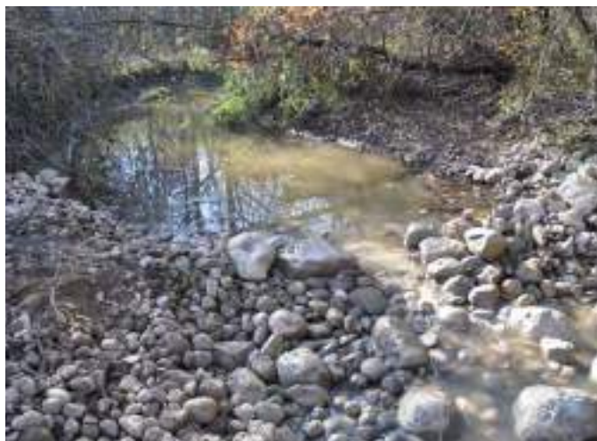
Figure B4-29. Seuil déversant Newbury.
