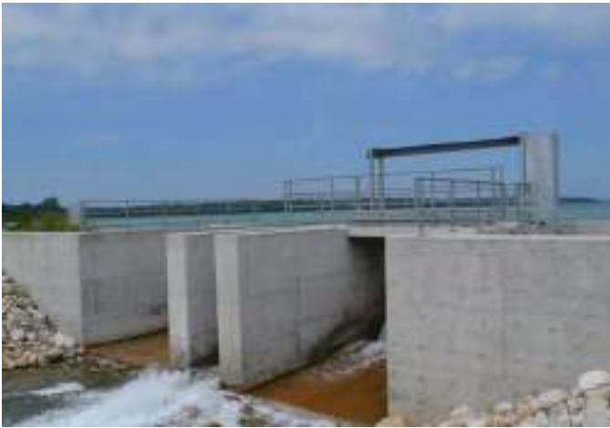
Figure A6-5. Barrage construit conformément aux dispositions de la Loi sur l'amélioration des lacs et des rivières (1990).
