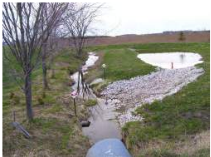
Figure B5-7. Drain Steenstra – Piège à sédiments après un épisode de débit élevé.
