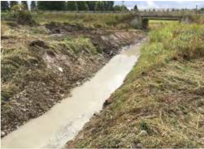
Figure A3-12. Nettoyage du fond et de la paroi gauche du talus d’un drain avec la végétation qui reste sur la paroi droite.
