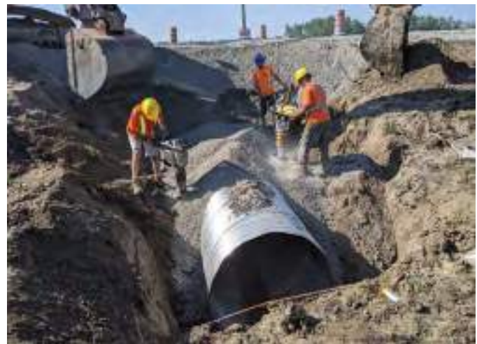
Figure A3-7. Remblai d'un nouveau ponceau.
