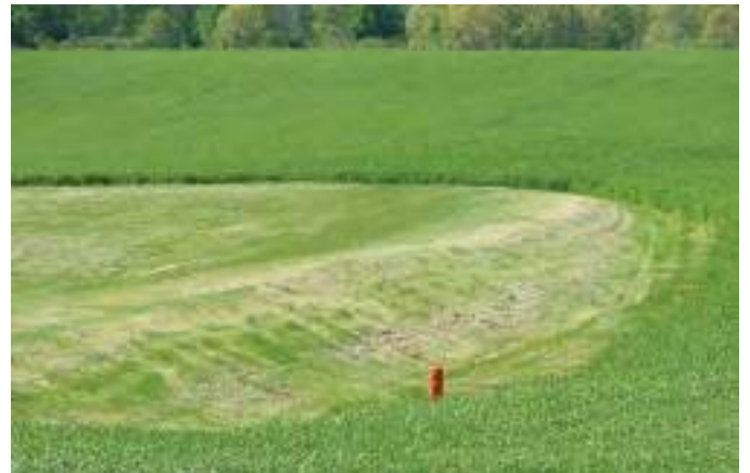
Figure B4-42. Bassin de sédimentation et de rétention des eaux avec une berme et une entrée d'eau.
