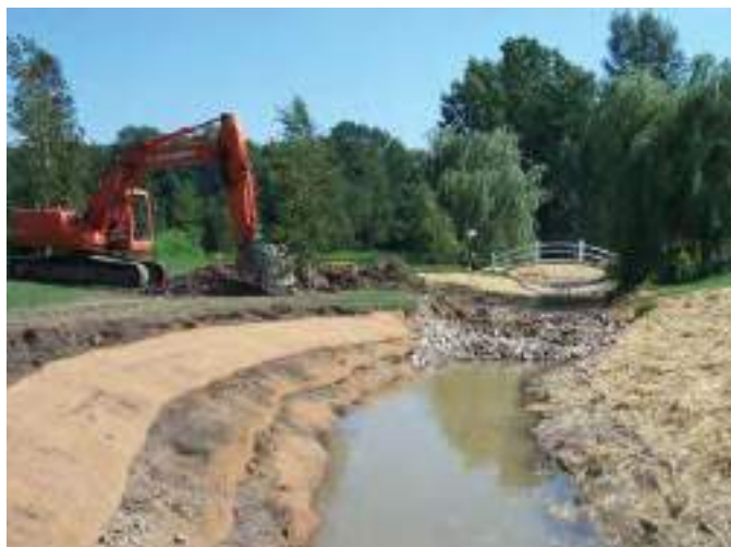
Figure B5-8. Drain Steenstra – Construction. Source : Municipalité de Central Huron, Ontario
