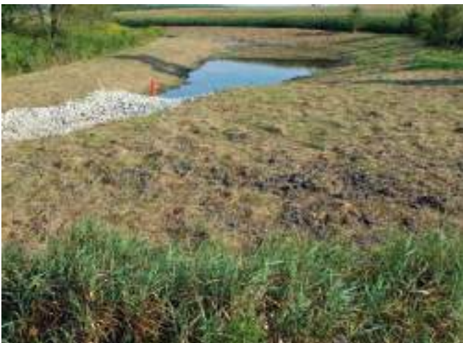
Figure B4-25. Paillis de foin/paille étendu sur du sol exposé autour d'un piège à sédiments.
