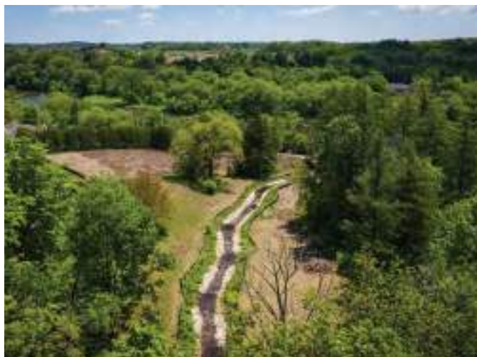
Figure B4-27. Nattes de végétation indigène – installées le long d'un drain.
