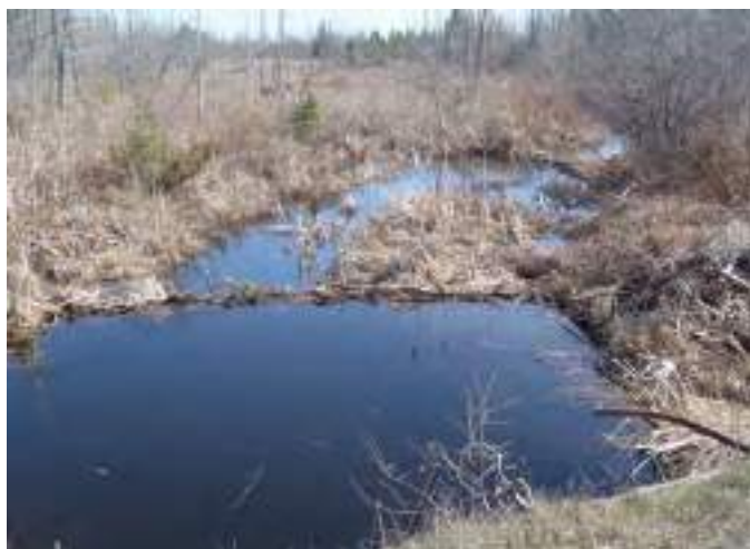
Figure B5-11. Drain du chemin Hazeldean – Obstruction dans le drain causée par l'activité des castors. Source : Ville d'Ottawa, Ontario
