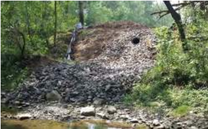
Figure A3-8. Stabilisation du talus et réparation du tuyau de sortie.
