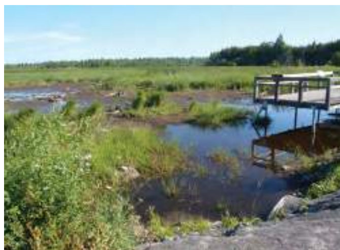
Figure B5-13. Drain du chemin Hazeldean – Plateforme d'observation du sentier transcanadien surplombant le drain. Source : Ville d'Ottawa, Ontario
