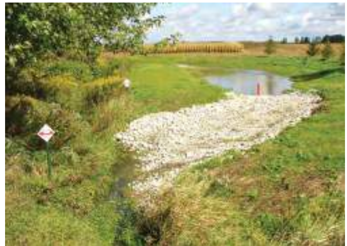
Figure B4-34. Exemple d'un piège à sédiments hors ligne. Source : Office de protection de la nature d'Ausable Bayfield, Ontario
