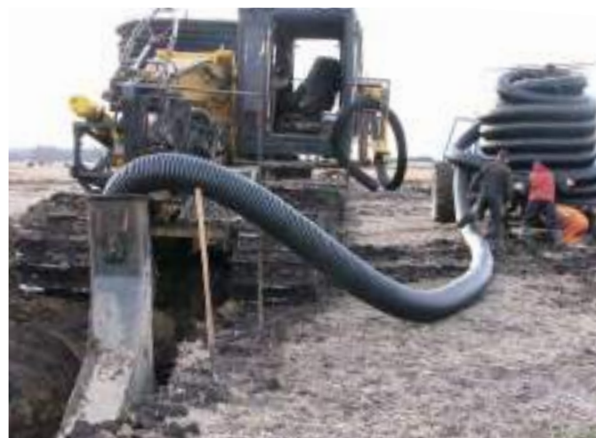
Figure A6-3. Installation de tuyaux de drainage.
