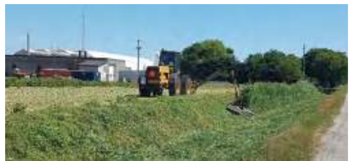
Figure B5-26. Kingsville – Tonte des phragmites dans le drain avec une tondeuse à rampe.
