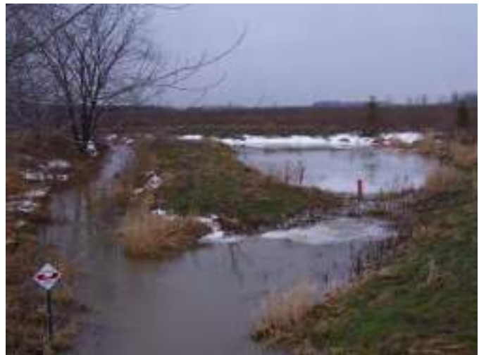
Figure B5-6. Drain Steenstra – Piège à sédiments construit.
