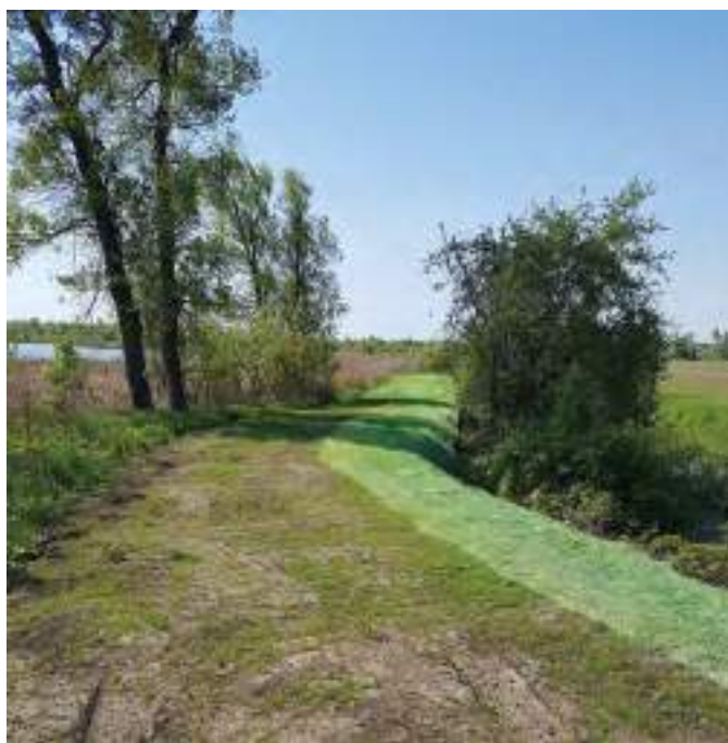
Figure A3-9. Digue récemment réparée. Source : Ville de Bradford West Gwillimbury, Ontario
