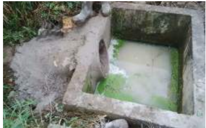
Figure A3-14. Réparation d'une boîte de raccordement. Source : Dietrich Engineering Ltd., Kitchener, Ontario
