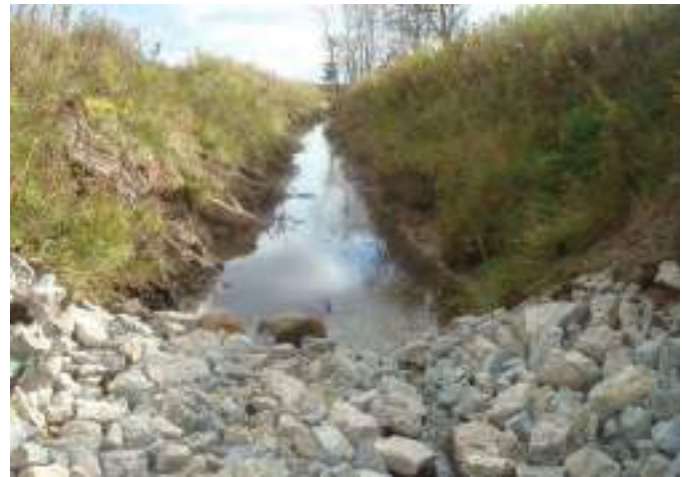
Figure B4-9. Un barrage de correction en pierre installé dans un drain.
