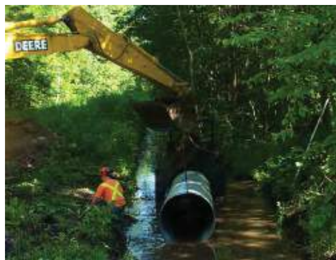
Figure B5-16. Ruisseau Dry – Installation d'une des structures de contrôle de l'eau.
