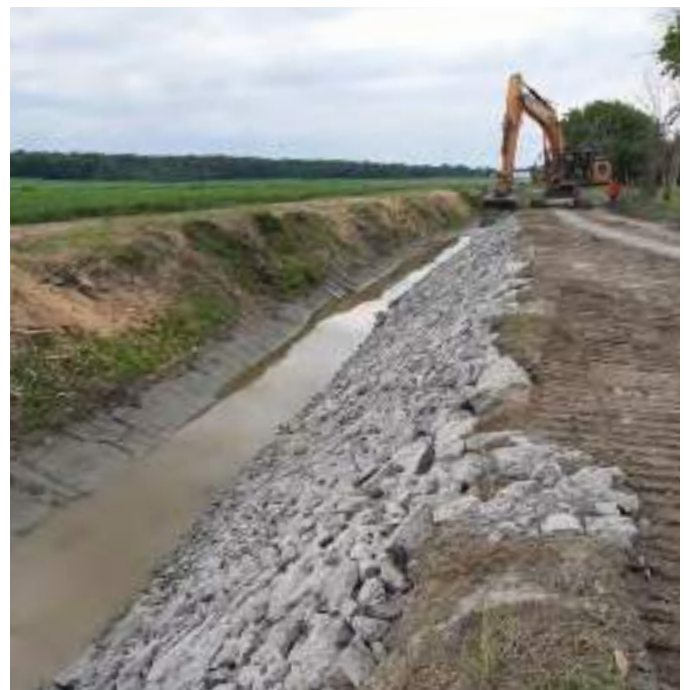
Figure B4-31. Enrochement de protection d'un drain. Source : Leroux Consultant, The Nation, Ontario
