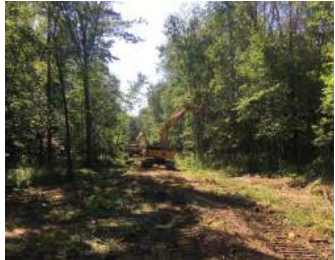
Figure A3-4. Débroussaillage du sommet du talus. Source : Dietrich Engineering Ltd., Kitchener, Ontario
