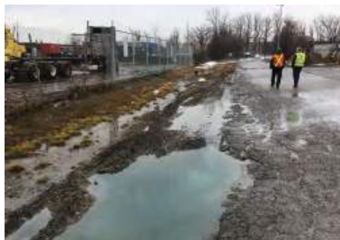
Figure B5-22. Southdown – Problèmes de drainage malgré la présence d'égouts pluviaux.
