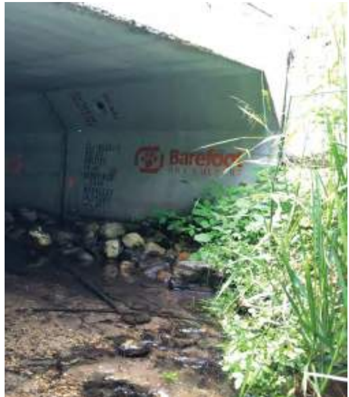
Figure B3-5. Exemple d'un élément d'infrastructure verte – ponceau Barefoot Box Culvert™ . Source : R.J. Burnside, Guelph, Ontario
