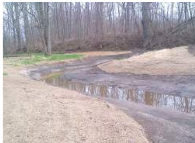
Figure B4-32. Produit en rouleau antiérosion installé sur les berges d'un drain.
