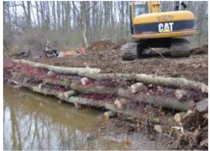
Figure B4-19. Construction d'un mur-caisson végétal. Source : Ian D. Smith, Lydian Environmental Consulting, Niagara Falls, Ontario
