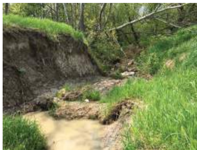
Figure B4-3. Sédimentation dans un drain causée par la défaillance de la berge d'un drain.
