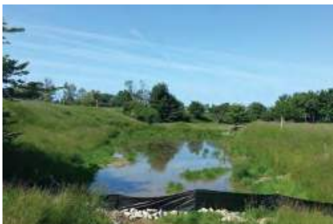
Figure B4-37. Clôture antiérosion installée à côté d'un drain.
