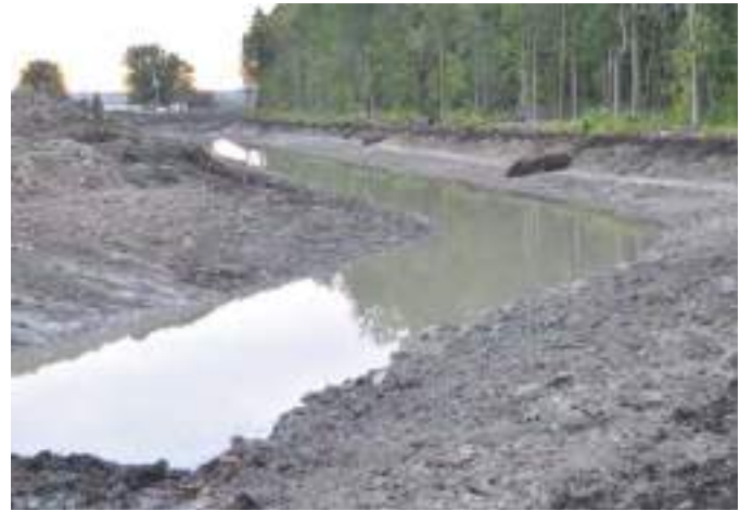
Figure B4-17. Canal dont l'eau a été enlevée, avec un plateau littoral sur le côté droit du canal.
