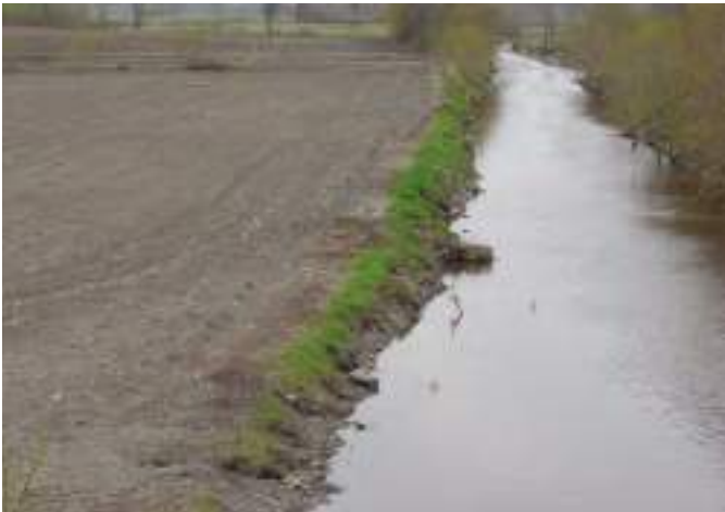
Figure A4-5. Dommages infligés à un drain municipal par l'enlèvement d'une bande tampon qui avait été incorporée au drain par le rapport de l'ingénieur et un règlement municipal.
