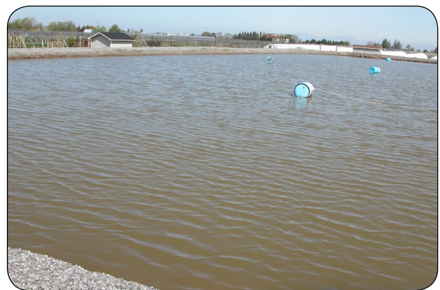
Figure 3. Exemple de réservoir hors-terre.
