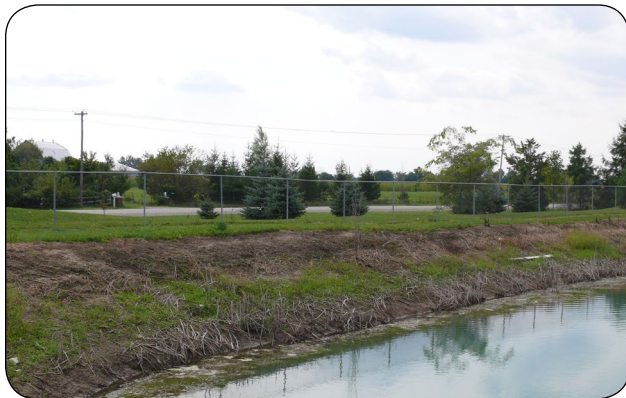
Figure 19. Clôture de sécurité entourant l'ensemble du réservoir.
