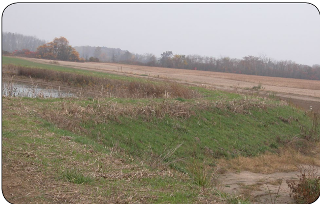
Figure 15. Réservoir partiellement hors-terre et partiellement excavé avec berges ensemencées.
