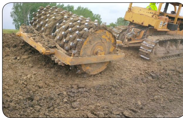
Figure 12. Compactage du sol à l'aide d'un rouleau à pieds de mouton.
