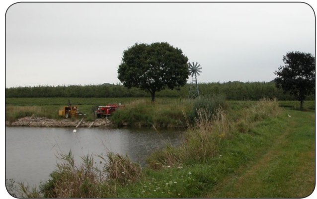
Figure 2. Exemple de réservoir creusé (sous le niveau du sol).
