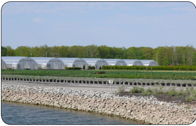
Figure 14. Enrochement empêchant l'érosion au niveau maximal.
