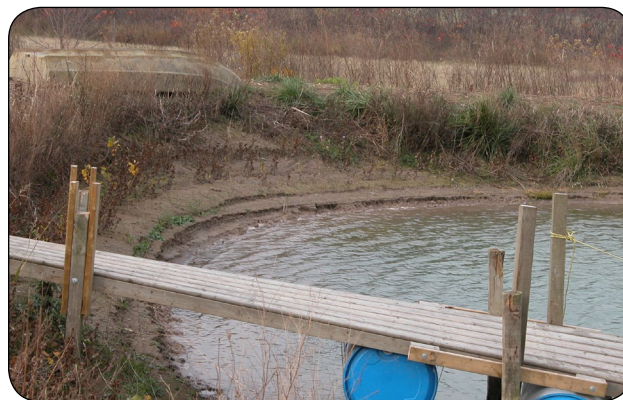
Figure 13. Érosion causée par les vagues au niveau maximal.
