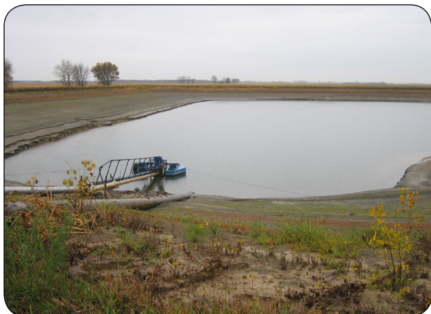
Figure 4. Exemple de réservoir combiné dont le volume d'entreposage est en partie sous le niveau du sol et en partie hors-terre.
