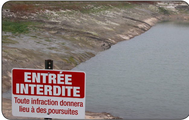
Figure 18. Panonceau interdisant l'accès à un réservoir.
