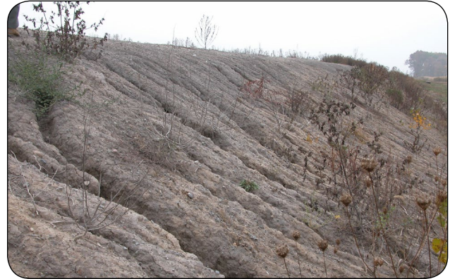
Figure 17. Exemple d'érosion grave d'une berme non ensemencée.
