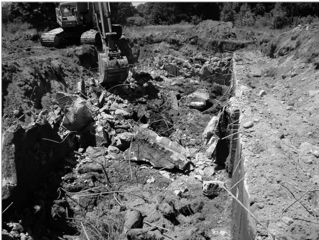
Figure 1. Démolition par une excavatrice d'une fosse à fumier désaffectée présentant un danger pour l'environnement. Les matériaux de démolition sont enfouis sur place.
