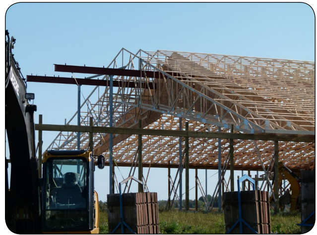
Figure 2. Étable en construction.
