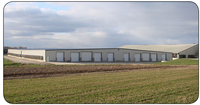
Figure 3. Étable laitière basse à ventilation longitudinale au Wisconsin.
