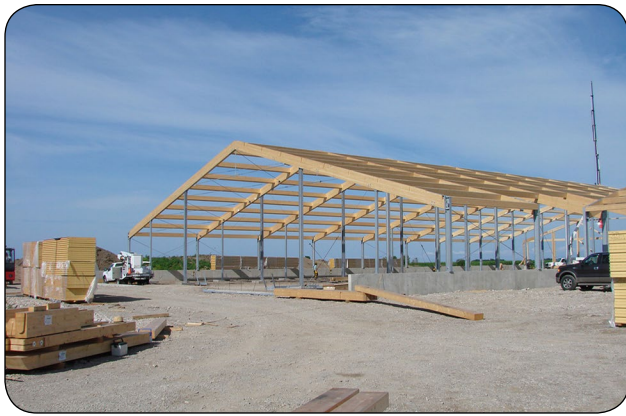
Figure 11. Bâtiment à ossature de bois préfabriqué destiné à servir d'étable laitière.
