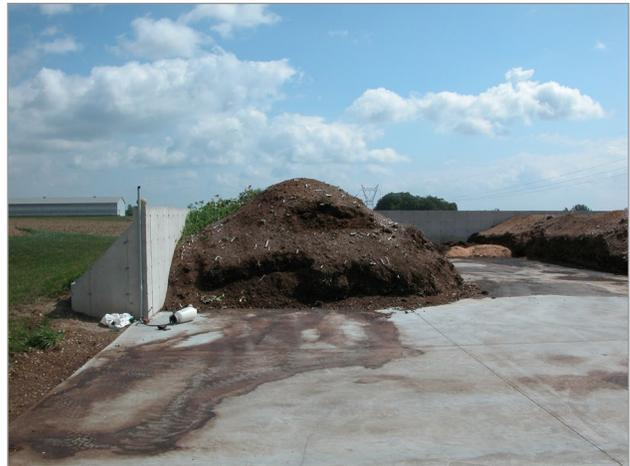
**Figure 3.** Purin s'échappant d'une installation d'entreposage de fumier solide.
