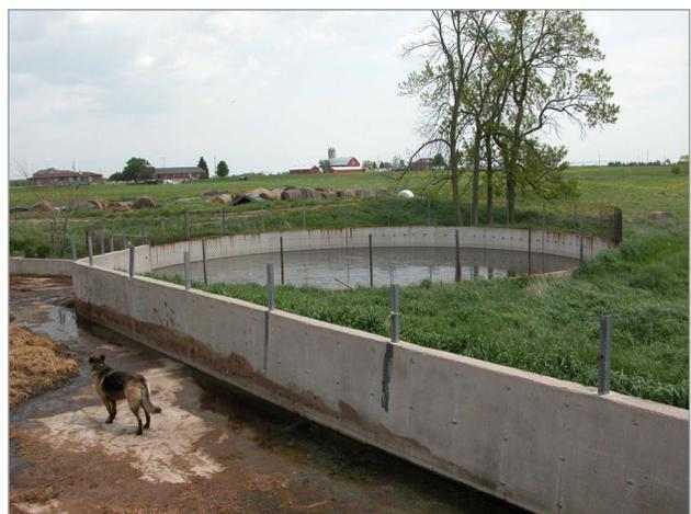
**Figure 5.** Installation de collecte du purin s'écoulant d'une cour de ferme.
