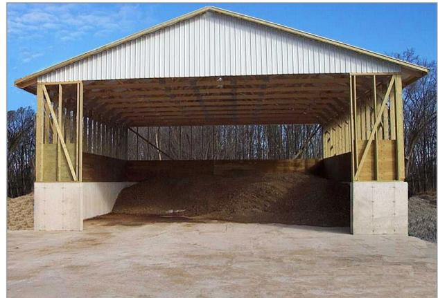
**Figure 1.** Un toit au-dessus d'une structure d'entreposage de fumier solide réduit le ruissellement, voire l'élimine.
