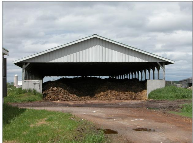
**Figure 4.** Installation d'entreposage d'éléments nutritifs solides couverte d'un toit.
