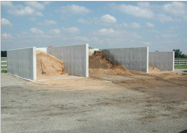
**Figure 2.** Exemple de structure à murs en béton, qui peut servir à entreposer du fumier.
