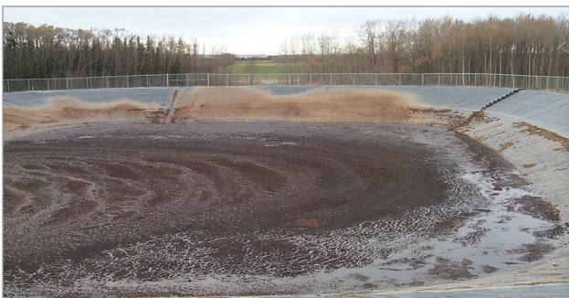
Figure 1. Structure d'entreposage en terre pourvue d'un revêtement synthétique destiné à offrir la protection nécessaire des eaux de surface et des eaux souterraines.
