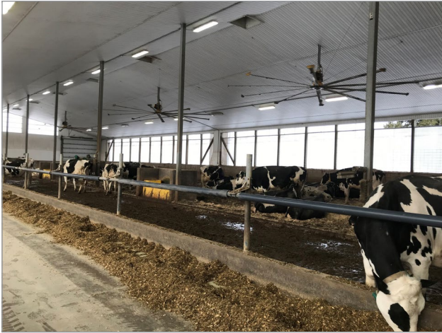
Figure 6. Ventilateurs à grand volume et vitesse basse dans une étable sur litière accumulée compostée.
