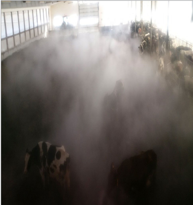
Figure 8. Le dégagement de vapeurs peut être problématique dans les étables sur litière accumulée compostée, en hiver.
