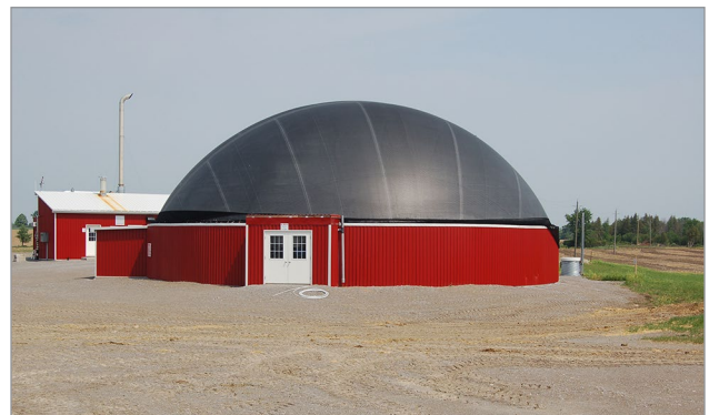
Figure 1. Digesteur de fumier sur une ferme laitière.
