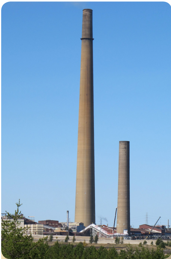
Arrêt 2 : Le complexe de la fonderie de Copper Cliff, vu du belvédère du Big Nickel.
