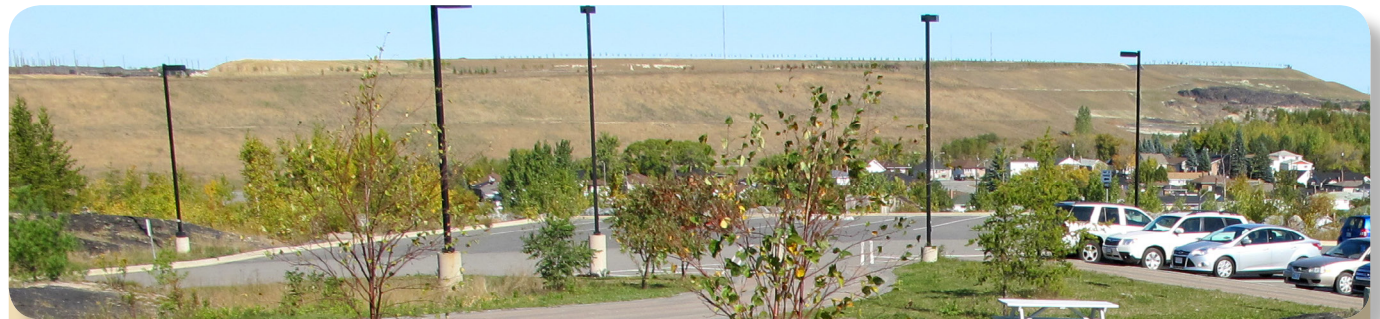
Arrêt 2 : De longues collines plates de laitier sont recouvertes de terre et de graminées.
