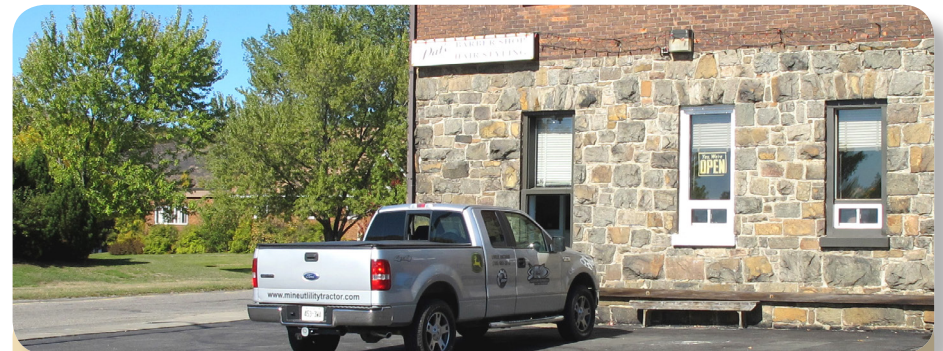
Arrêt 3 : L'ancien bureau de la Canadian Copper Company à l'angle des rues Godfrey et Market présente un mur de moellons équarris au premier étage.
