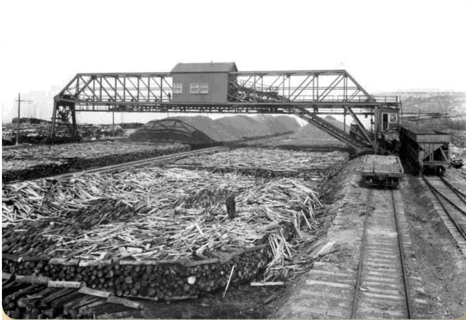
Arrêt 2 : Un pont mobile sur chevalets décharge le minerai des wagons sur une couche de billes en vue du grillage ouvert, au début des années 1900. Avec l'aimable autorisation de la Base historique du Grand Sudbury.
