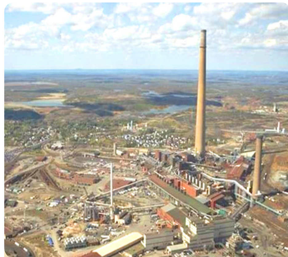
Vue aérienne du complexe de la fonderie de Copper Cliff. Avec l'aimable autorisation de Vale.
