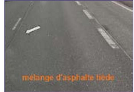
Figure 3 : Photos de sections en enrobés tièdes et en enrobés à chaud sur la route 11 montrant la qualité supérieure du joint longitudinal des enrobés tièdes.
