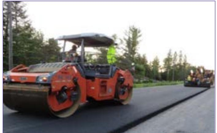
Opération de pavage d'asphalte à mélange chaud montrant un rouleau de chaussée.
