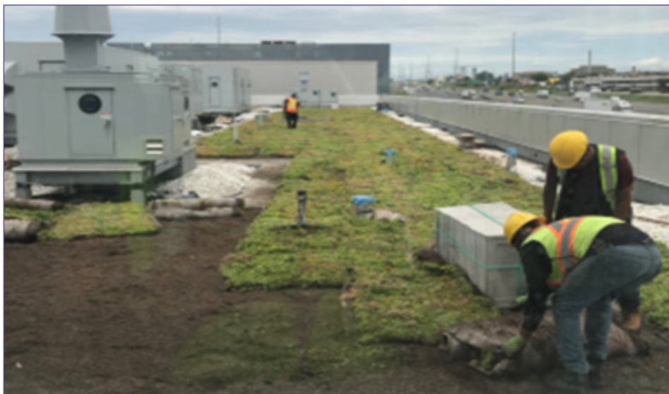
Installation d'un toit vert sur l'aile B du nouveau complexe CEIT.
