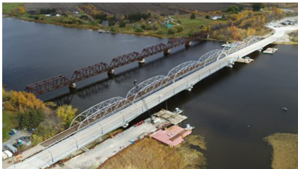
Le nouveau pont Baudette-Rainy River en construction et le pont construit en 1958, maintenant désaffecté, côte à côte.
