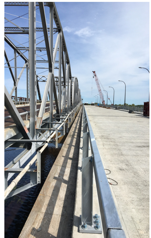
Vue de l'espace étroit entre l'ancien pont, à gauche, et le nouveau pont, à droite.
