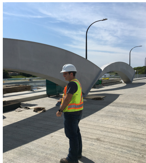
Tyler McQuaker (MTO) effectue une inspection visuelle de segments d'arche avant leur installation.
