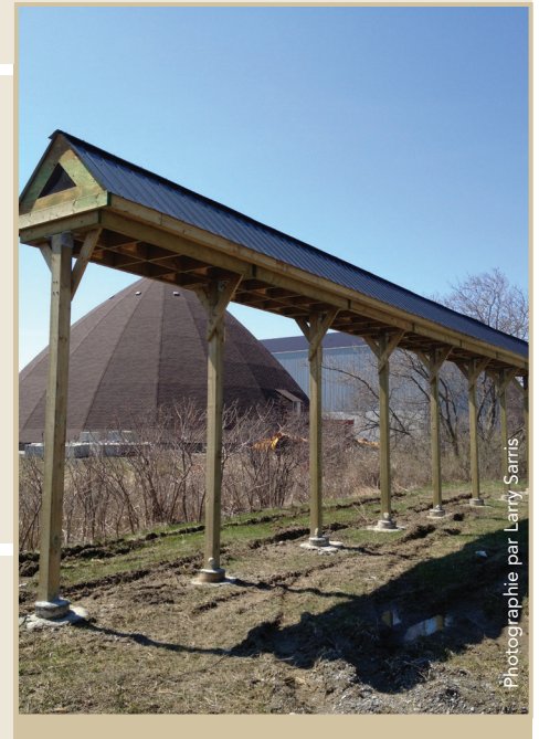
Photographie par David Bradley
