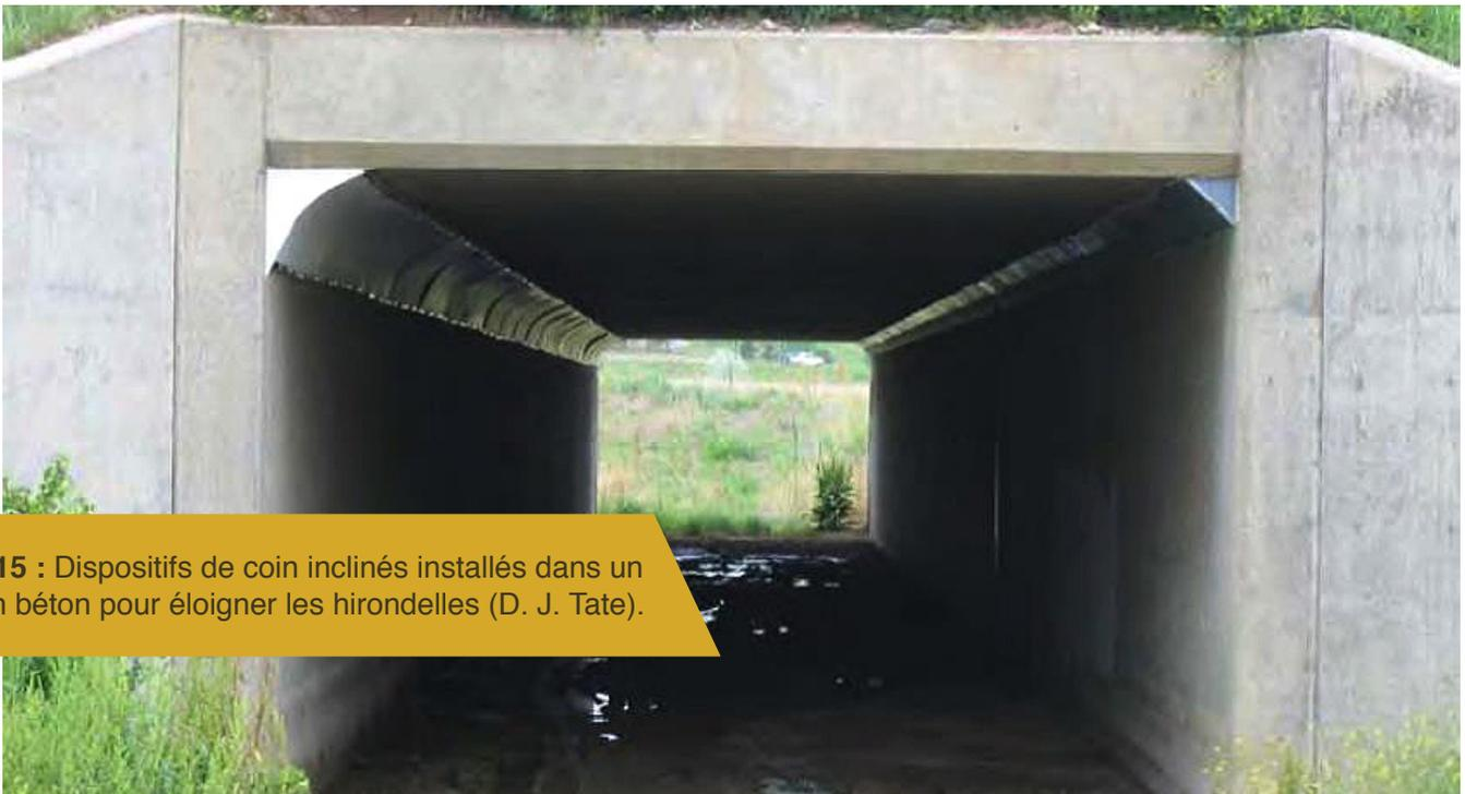
**Photo 15** : Dispositifs de coin inclinés installés dans un dalot en béton pour éloigner les hirondelles (D. J. Tate).
