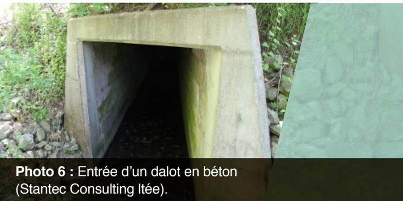
**Photo 6** : Entrée d'un dalot en béton (Stantec Consulting ltée).
