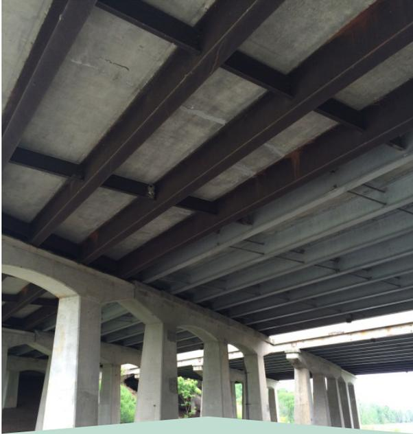
**Photo 11** : Poutres de la face intérieure d'un pont avant l'installation de panneaux contreplaqués (L. Sarris).
