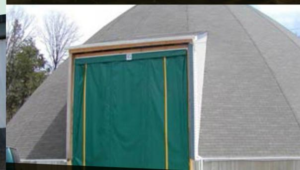
**Photo 23** : Rideau à l'entrée d'un entrepôt de sel ou de sable (<http://gatewayindustrial.com/salt-dome/doors.html>)
