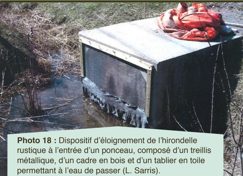
**Photo 18** : Dispositif d'éloignement de l'hirondelle rustique à l'entrée d'un ponceau, composé d'un treillis métallique, d'un cadre en bois et d'un tablier en toile permettant à l'eau de passer (L. Sarris).
