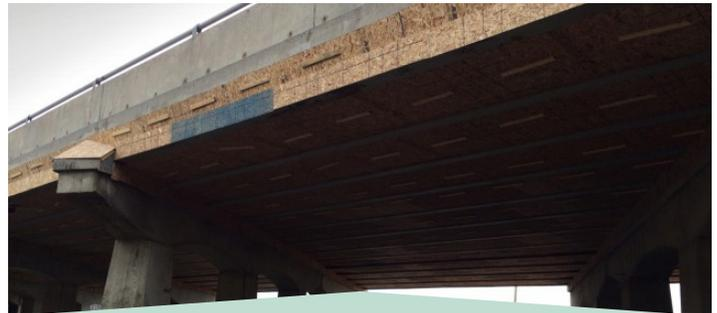
**Photo 13** : Panneaux contreplaqués installés sur les côtés d'un grand pont surplombant un canal (L. Sarris).
