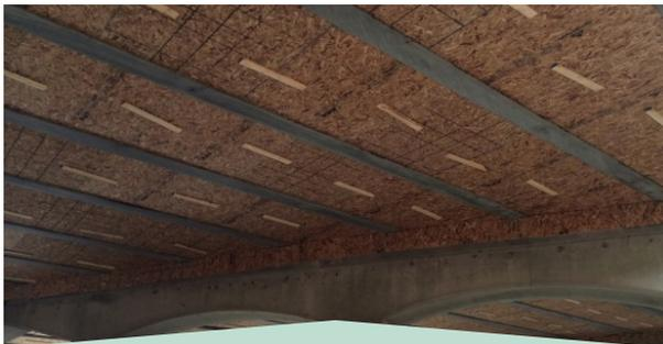
**Photo 12** : Poutres de la face intérieure d'un pont après l'installation de panneaux contreplaqués (L. Sarris).
